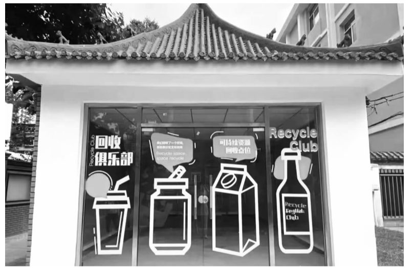
已建成投入使用的“井点”二号
